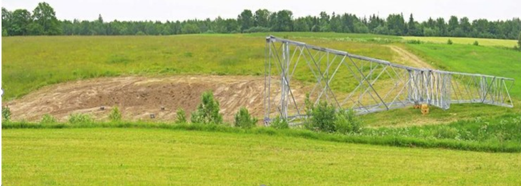
2.3.2 pav. Statybos aikštelė su nuimtu dirvožemio sluoksniu (R. Milerio nuotrauka, statoma OL Klaipėda–Telšiai).
