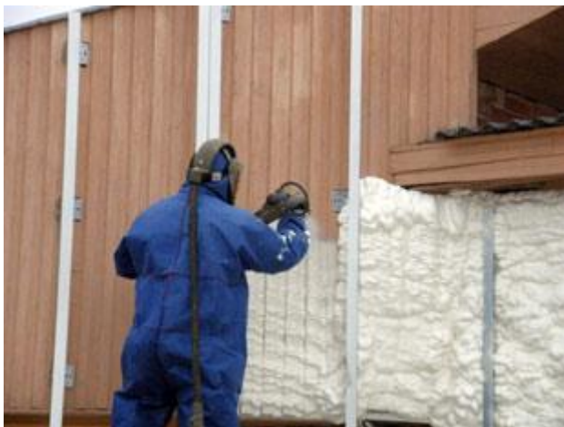
Termovata ant sienos purškiama skystu pavidalu. Autoriaus nuotr.
