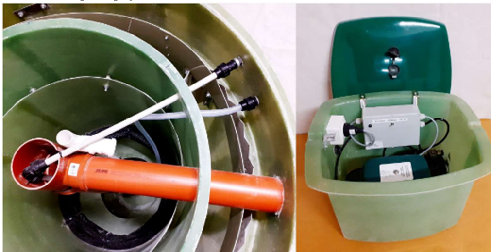
3 pav. Biologinio valymo įrenginio konstrukcijoje montuojami technologiniai įrenginiai
