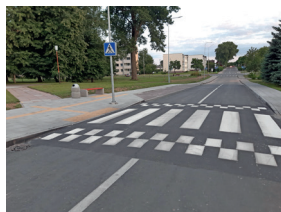
Remontuojamos Ignalinos miesto gatvės, daugiabu- čių namų kiemai
