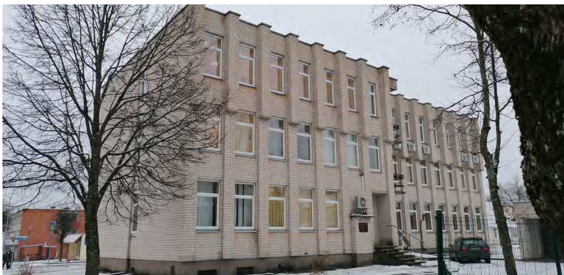
Esamo pastato vaizdas iš kiemo pusės, 2 pav.
