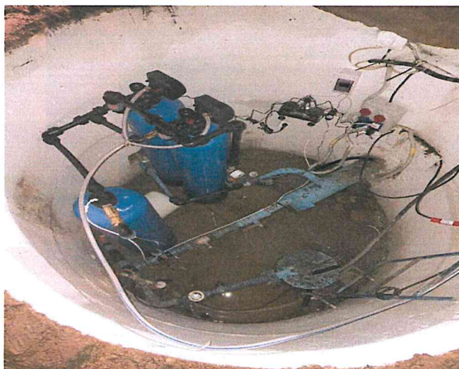
14 pav. Kazokinės nugeležinimo įrenginys
