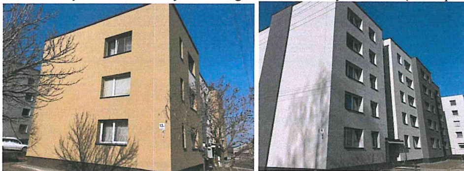
12 pav. Renovuoti DGN Vidiškių miestelyje
